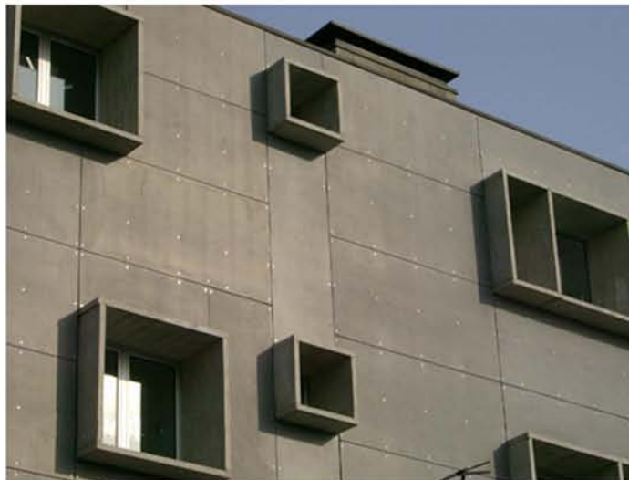
Sistema di protezione facciata mediante doghe in zinco - titanio
