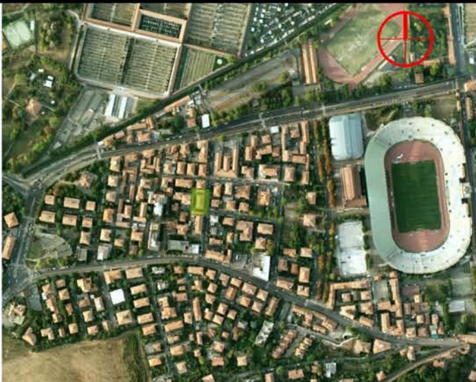
Lotto in zona residenziale, area ovest, ad alta densità.
