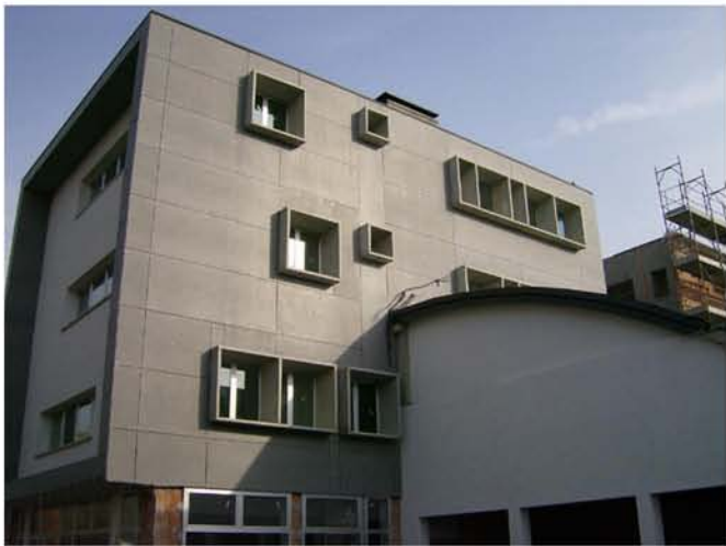
Protezione delle aperture mediante aggetti
