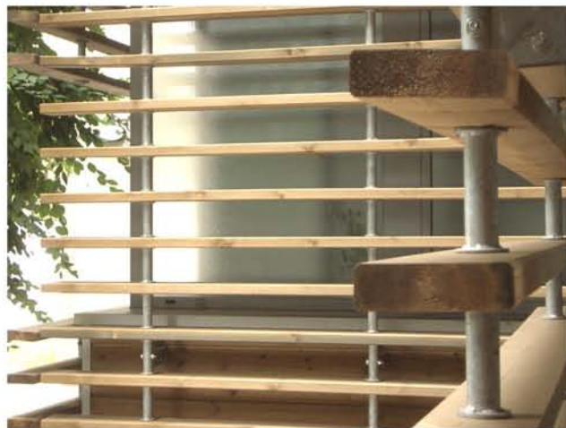
Doghe in legno poste a brise-soleil per consentire controllo della radiazione solare
